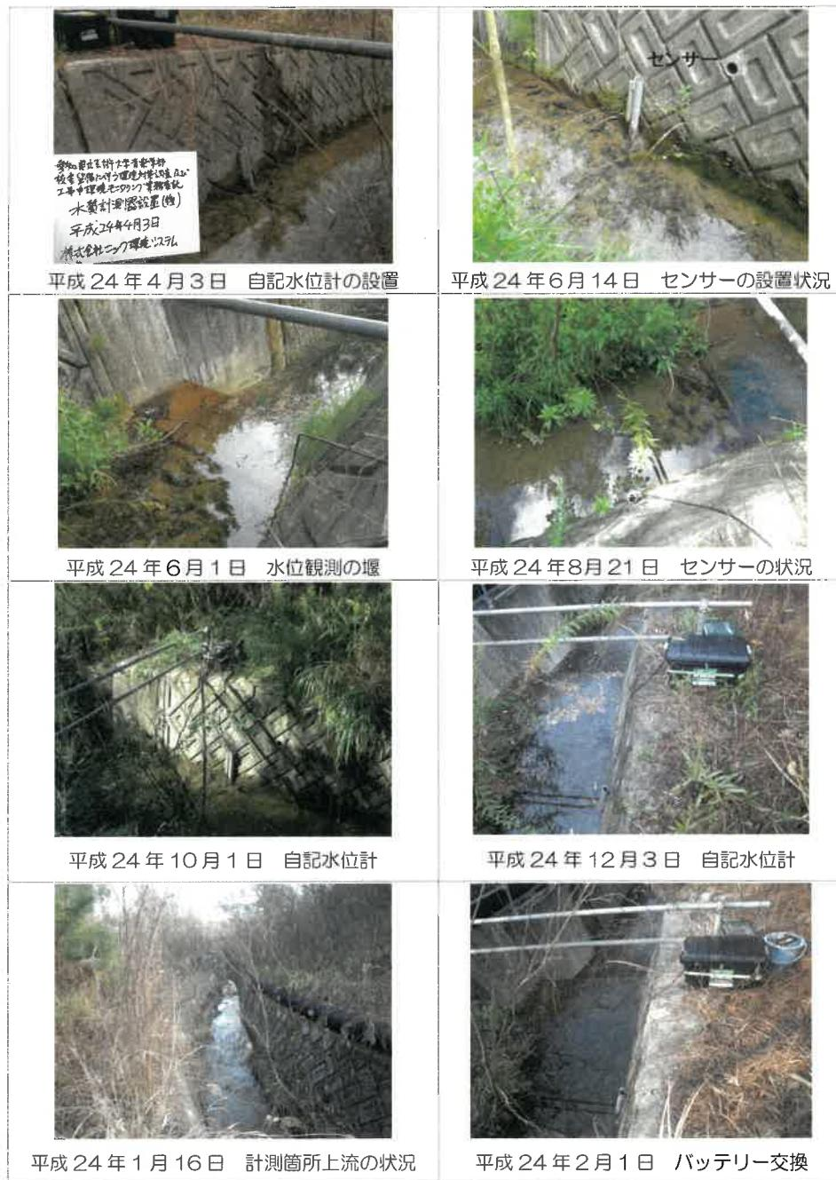
写真 3-1-1 自記水位計による水位モニタリング調査状況
