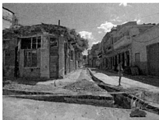
写真5 工事中の道路
